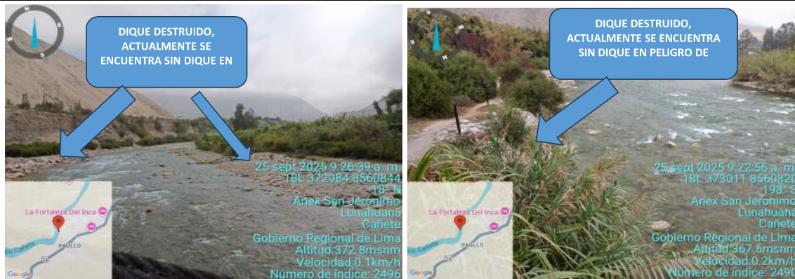
FIGURA N°01: EL RIO CAÑETE PRESENTA UN CAUCE CON COLMATACIÓN CRÍTICA POR SEDIMENTACIÓN, DONDE LA MARGEN IZQUIERDA Y DERECHA, ADEMÁS SE VISUALIZA QUE NO CUENTA CON DIQUES, EL CUAL GENERA UN RIESGO EN DESBORDES Y POSIBLES DAÑOS EN CAMPOS DE CULTIVO Y VIVIENDAS.
