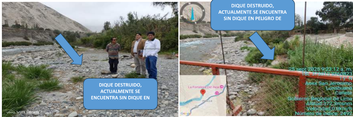
FIGURA N°01: EL RIO CAÑETE PRESENTA UN CAUCE CON COLMATACIÓN CRÍTICA POR SEDIMENTACIÓN, DONDE LA MARGEN IZQUIERDA Y DERECHA, ADEMÁS SE VISUALIZA QUE NO CUENTA CON DIQUES, EL CUAL GENERA UN RIESGO EN DESBORDES Y POSIBLES DAÑOS EN CAMPOS DE CULTIVO Y VIVIENDAS.
